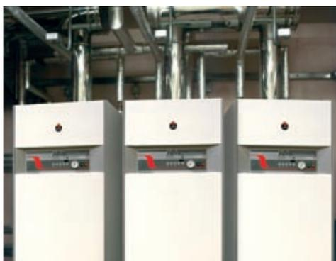
HeatMaster TC è progettato per funzionare in cascata o in parallelo per le applicazioni del terziario e industriali che necessitano di grandi volumi di acqua calda.
