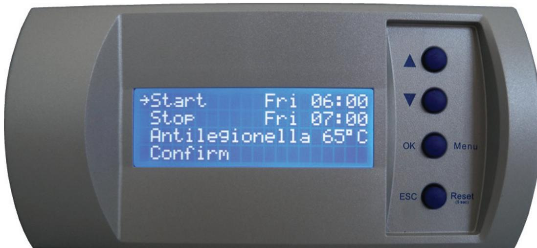
Il comando remoto può essere collocato in un locale distante fino a 100 metri dal gruppo termico ed è dotato di una batteria tampone e di un display retroilluminato. Il dispositivo consente, attraverso il menù generale, di accedere a 4 sottomenù per il controllo di nuove funzionalità quali:
