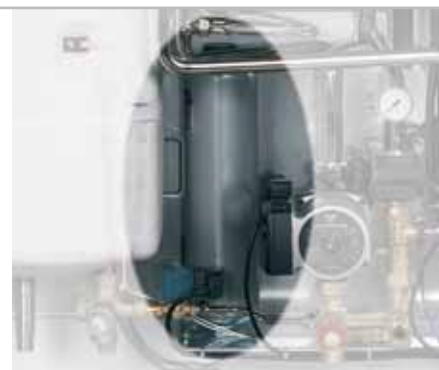
vaso di espansione sanitario
