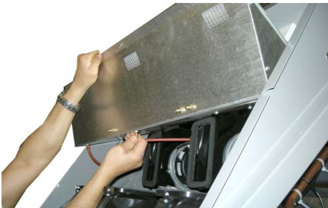
Rimuovere i tubi in silicone rossi e poi la camera ventilatori.
