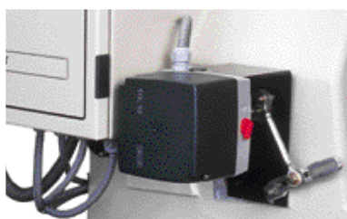
Servocomando elettrico per la regolazione dell'aria
