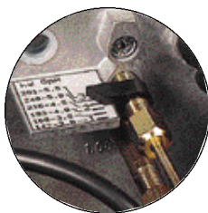
Regolazione testa di combustione
