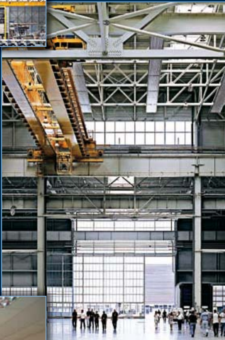
TERMOSTRISCE RADIANTI DUCK STRIP : AEROSPATIALE TOULOUSE FABBRICA DEL NUOVO AEREOPLANO AIRBUS A380 ALTEZZA DI INSTALLAZIONE: 40 m
