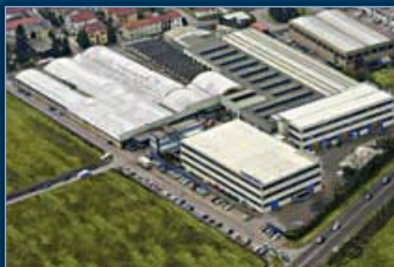
Lo stabilimento Sabiana di Corbetta
