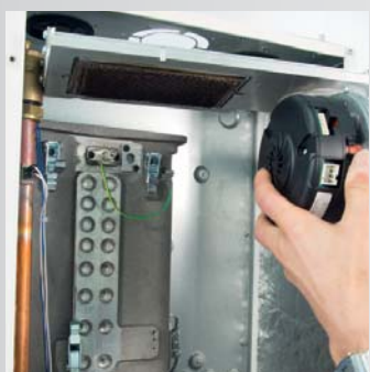
Rimozione del sistema di combustione completo
