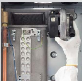
Rimozione del sistema di combustione completo
