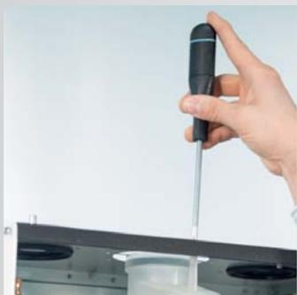
Rimozione vite blocco collettore fumi
