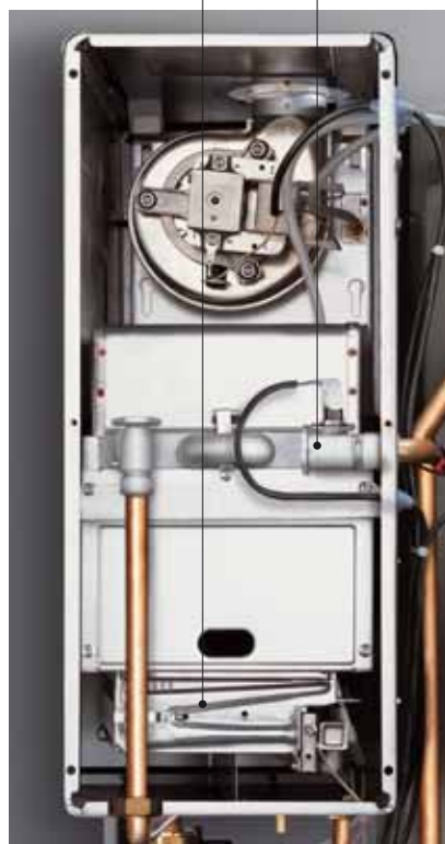
Particolare camera a tiraggio forzato
