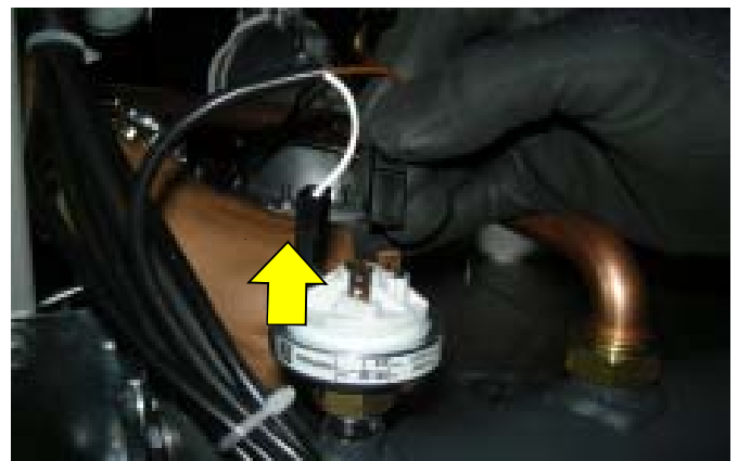
- Rimuovere la connessione pressostato gas
