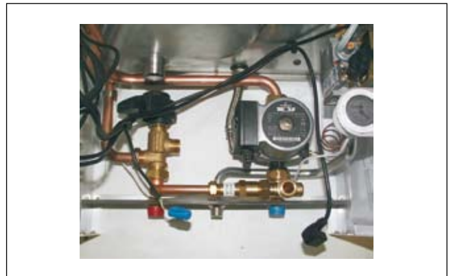
Figura: raccordi idraulici dopo lo smontaggio della parte sanitaria
