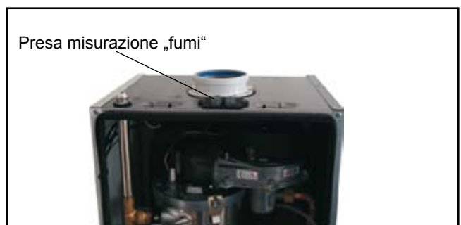
Figura: Analisi fumi con l'apparecchio aperto
