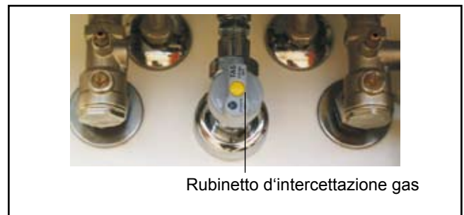
Figura: dispositivi d'intercettazione
