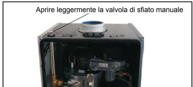
Figura: valvola di sfiato manuale (posta sopra la caldaia)
