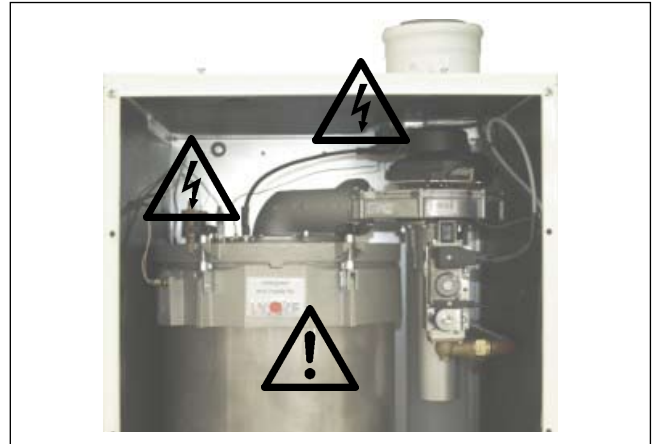
Figura: trasformatore di accensione, elettrodo di accensione ad alta tensione, scambiatore Pericolo per tensione elettrica Pericolo di ustioni per componenti molto caldi
