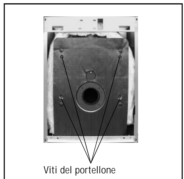
Figura: smontaggio portellone caldaia
